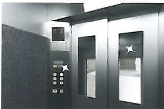
エレベーターまわり
