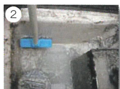
デッキブラシによる洗浄作業
