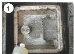
GT ファイナルクリーン投入
